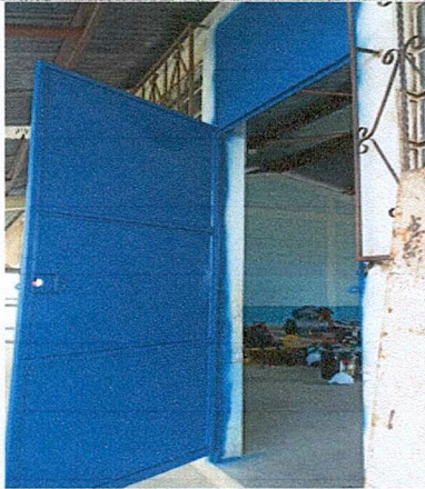
Foto 3: INSTALACIÓN DE PUERTA
