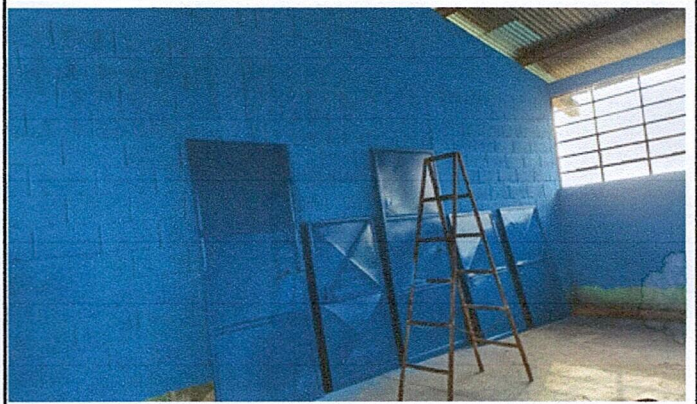
Foto 2: REMOZAMIENTO PUERTAS DE METAL
